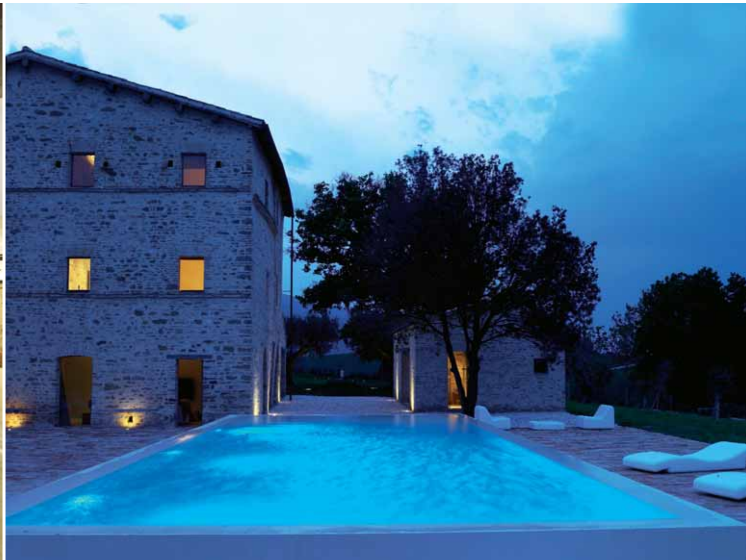
L'espace intérieur, ci-contre, entièrement repensé par les architectes, s'articule autour de volumes contemporains respectant la structure existante. Bloc cuisine en acier inoxydable, Arclinea. Sobriété linéaire de la façade, à droite, qui s'illumine la nuit tombée.
